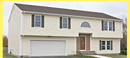
Casas novas em construção EAST PROVIDENCE $349.900
